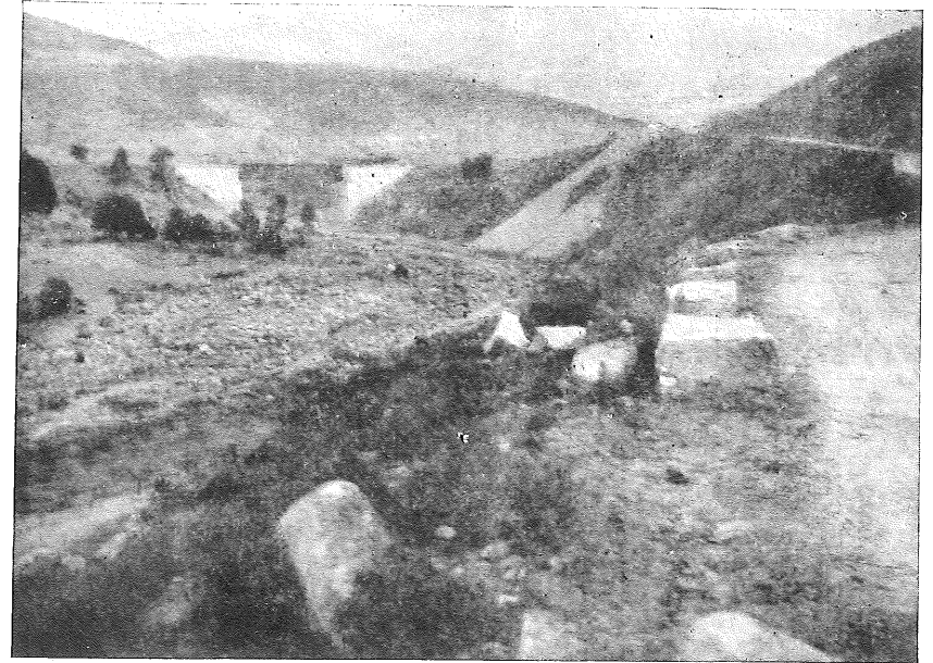
Puente sobre el Río Francolí. Paso del ferrocarril de Reus a Lérida.
